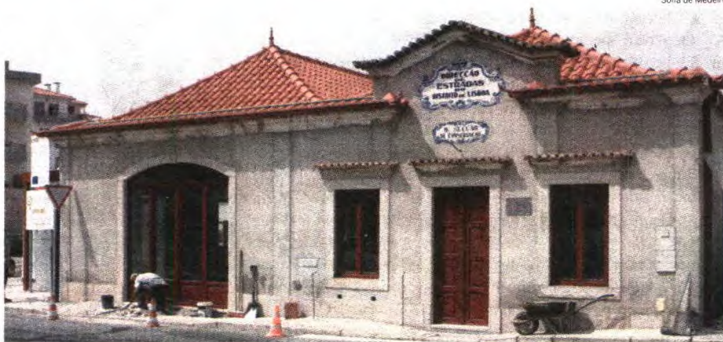
▲ OBRAS: reabilitação integral da antiga Casa dos Cantoneiros é um dos projectos municipais lourinhanenses
